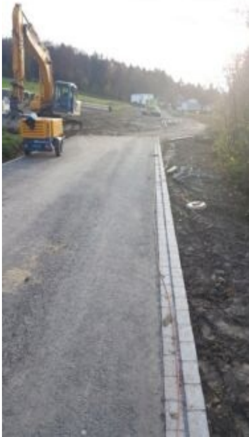
Randsteine werden gesetzt Belagseinbau noch im Herbst
