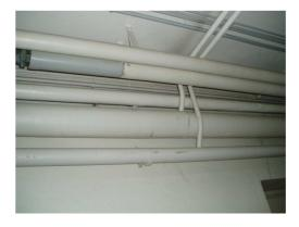
Isolierte Hauptvorlaufleitung und nicht isolierte Rücklaufleitung mit Abgängen zu Steigzonen EG bis 3.OG
