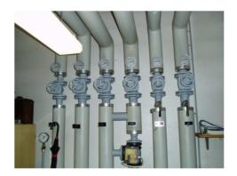
Bestehende Heizungsverteilung mit zwei Heizgruppen an gleicher Aussentemperatursteuerung
