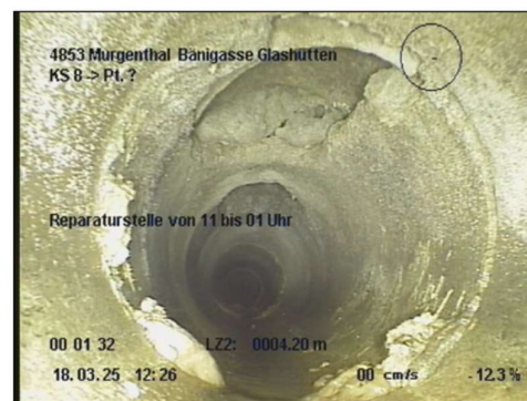
Foto: 15_5A, 00:01:31 4.2m, Reparaturstelle von 11 bis 01 Uhr
