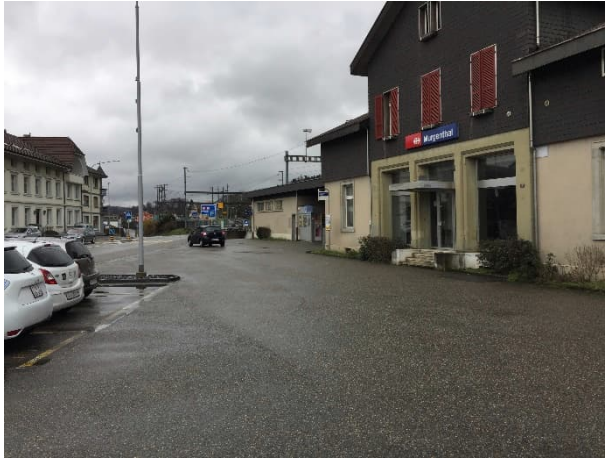
Bild 1: Ist Zustand, Ansicht von Westen
