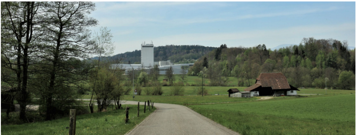
Unmassstäbliche Industriebauten am Siedlungsrand beeinträchtigen das Landschaftsbild massiv.
